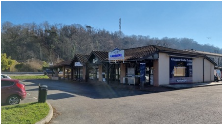
Les toitures des bâtis en zone commerciale, février 2022
