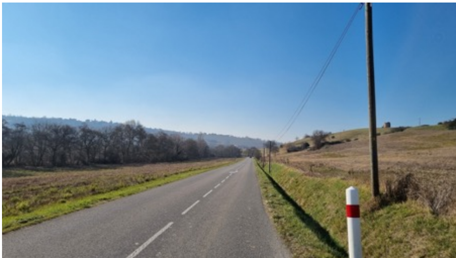
Entrée de ville, RD24E, février 2022
