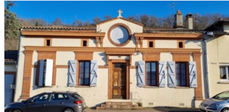
Bâti remarquable, février 2022
