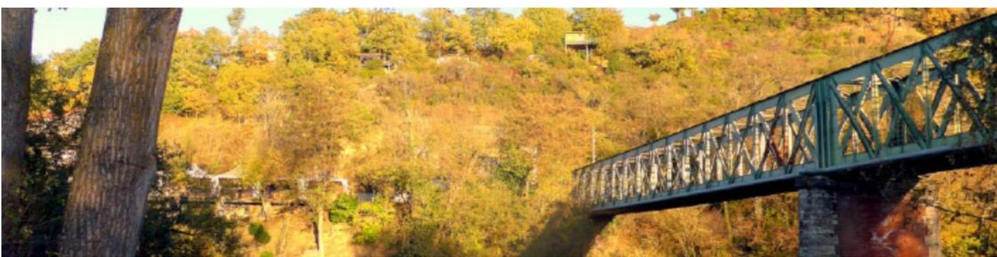
**Pont en fer.** Le pont en fer de 120 mètres de long, construit en 1903, permettait de franchir la rivière et de rentrer dans Lacroix-Falgarde depuis Pinsaguel. À la suite de l'incendie d'un véhicule qui a fragilisé sa structure, celui-ci a été fermé à la circulation en 2011.
